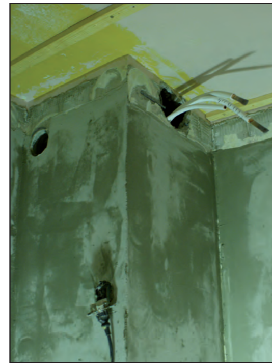
Märkätila on pohjustettu vesieristystä varten
