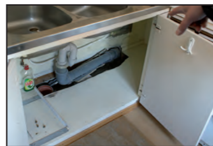
Keittiön haaraviemärit uusitaan
