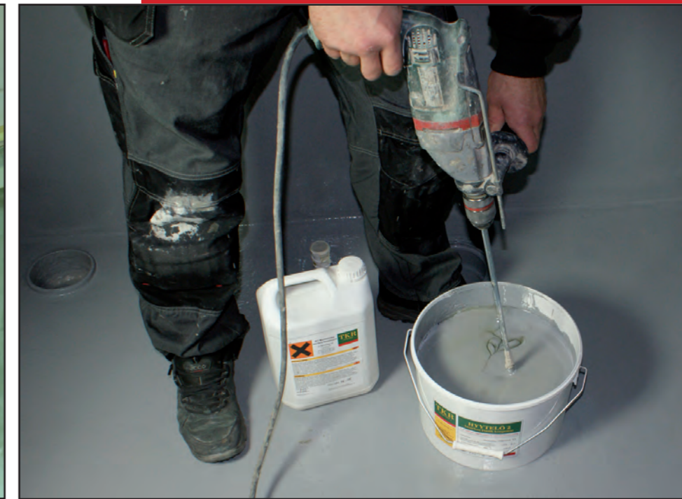
TKR-Putkimassan sekoitus käy helposti tuotepakkauksissa ja vispiläkoneella. Myrkyllisiä kaasuja ei erityy, vaan aine on lähes hajutonta
